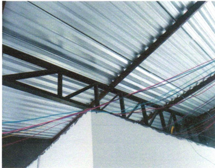
Foto 15 CABO DE COBRE FLEXÍVEL ISOLADO, 4 MM 2 , ANTI-CHAMA 450/750 V, PARA CIRCUITOS TERMINAIS - FORNECIMENTO E INSTALAÇÃO. AF_12/2015
