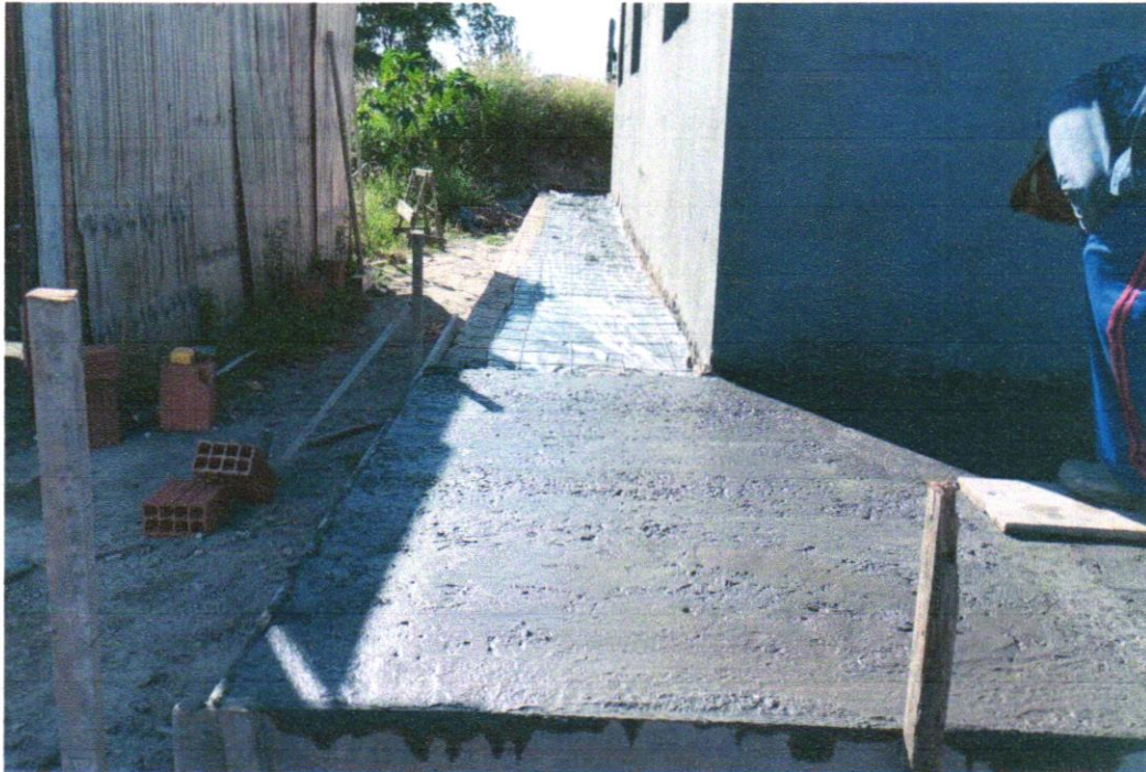
Foto 21 EXECUÇÃO DE PASSEIO (CALÇADA) OU PISO DE CONCRETO COM CONCRETO MOLDADO IN LOCO, USINADO, ACABAMENTO CONVENCIONAL, NÃO ARMADO. AF_07/2016
