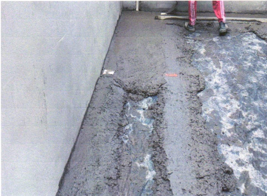
Foto 19 - PISO EM CONCRETO 20 MPA PREPARO MECÂNICO, ESPESSURA 7CM. AF_09/2020
