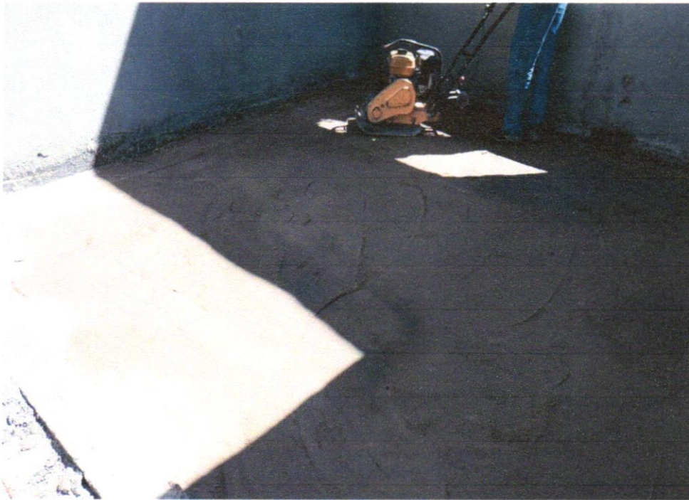
FOTO 25 - Regularização mecanizada de áreas
