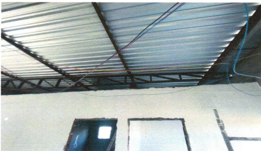
FOTO 04 - TELHAMENTO COM TELHA METÁLICA TERMOACÚSTICA =30MM, COM ATÉ 2 ÁGUAS, INCLUSO IÇAMENTO. AF_07/2019
