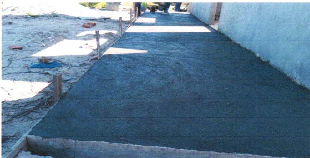
FOTO 22 - EXECUÇÃO DE PASSEIO (CALÇADA) OU PISO DE CONCRETO COM CONCRETO MOLDADO IN LOCO, USINADO, ACABAMENTO CONVENCIONAL, NÃO ARMADO. AF_07/2016
