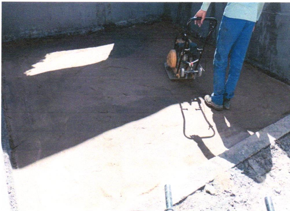
FOTO 26 - Regularização mecanizada de áreas
