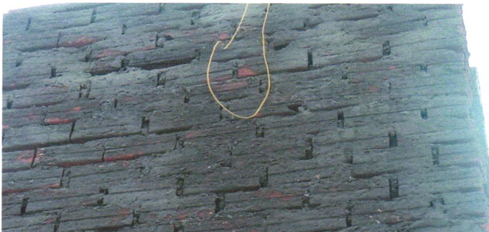
FOTO 02 – CHAPISCO APLICADO EM ALVENARIAS E ESTRUTURAS DE CONCRETO INTERNAS, COM COLHER DE PEDREIRO. ARGAMASSA TRAÇO 1:3 COM PREPARO EM BETONEIRA 400L.
